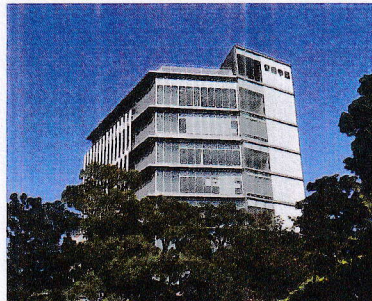
南館（中学棟）は窓を広く取り、光あふれる明るい校舎となっている
